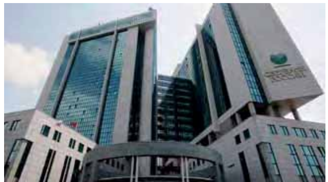
SBER-BANK (Moscú – Rusia) Equipos: enfriadora RGA, fancoils TOP FAN
