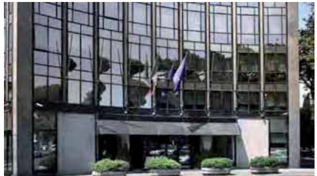
Sede Finmeccanica (Roma – Italia) Equipos: enfriadora RGA
